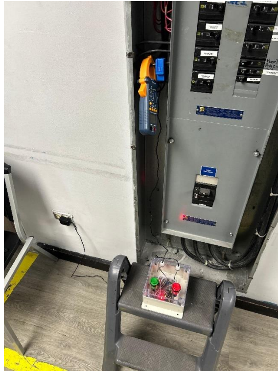
Figura 29. Instalación del prototipo de monitoreo y amperímetro de gancho. Fuente: Elaboración propia.
