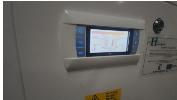
Figura 7.36: Ensayo de sistema geotérmico
