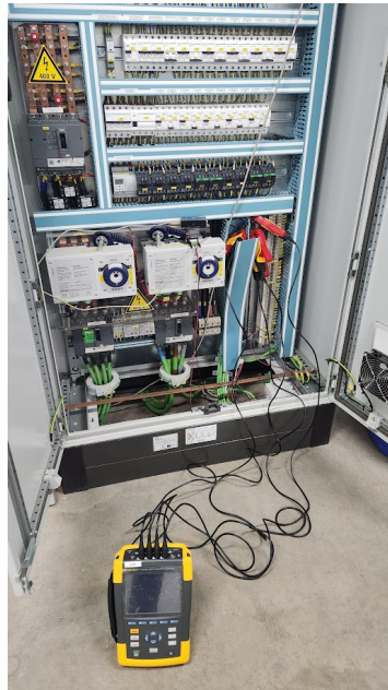
Figura 7.35: Ensayo de sistema geotérmico
