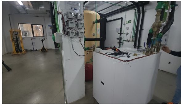
Figura 7.34: Ensayo de sistema geotérmico
