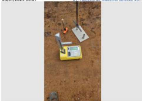
Descripción Prueba de compactación
