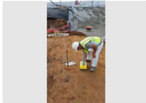
Descripción Prueba de compactación
