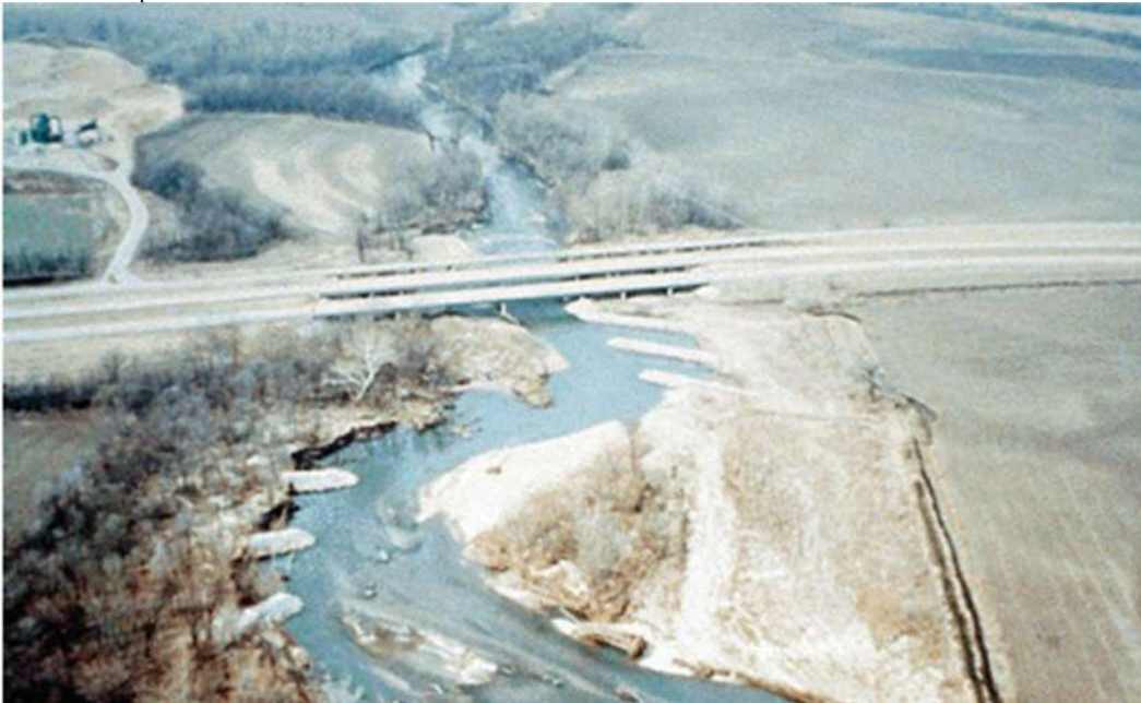
Fuente: Tomado de FHWA Bridge Inspector's Manual Section 11.1 and 11.2 - Waterways (Rossow, 2012)
