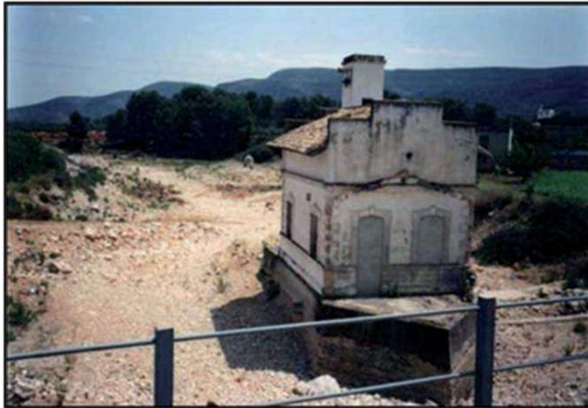
Figura 24. Presencia de estructuras en el cauce
