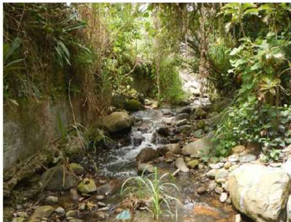
Figura 30. Presencia de estructuras en el cauce (Condición 3)
