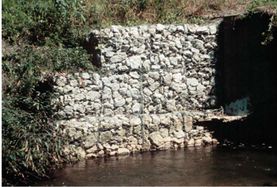
Fuente: Tomado de FHWA Bridge Inspector's Manual Section 11.1 and 11.2 - Waterways (Rossow, 2012)
