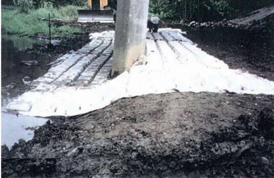
Fuente: Tomado de FHWA Bridge Inspector's Manual Section 11.1 and 11.2 - Waterways (Rossow, 2012)
