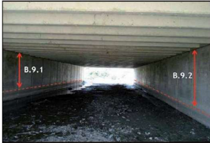
Figura 13. Medición del nivel máximo del agua.
