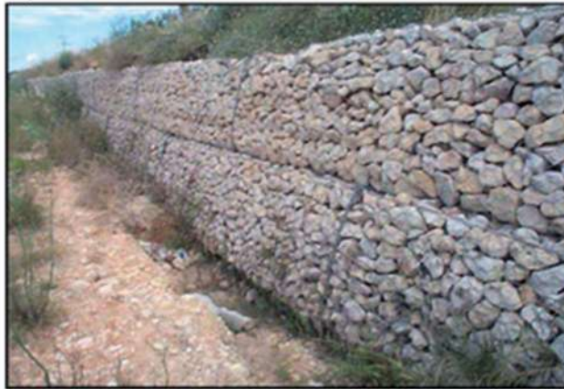
Figura 19. Protecciones en los márgenes sin daños
