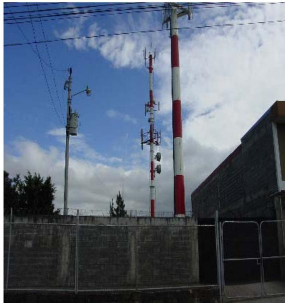
**Figura A.3.9** Monopolo ubicado en estación base Zapote.
