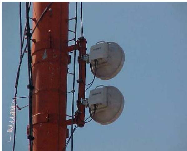
**Figura A.3.18** Antenas para transmisión por microondas en estación base Bellavista.
