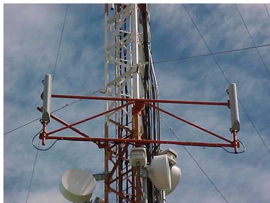
**Figura A.3.22** Antenas para transmisión por microondas en estación base Llorente.
