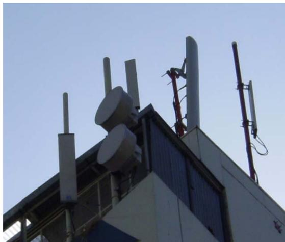
**Figura A.3.16** Antenas para transmisión por microondas en estación base Hospital.
