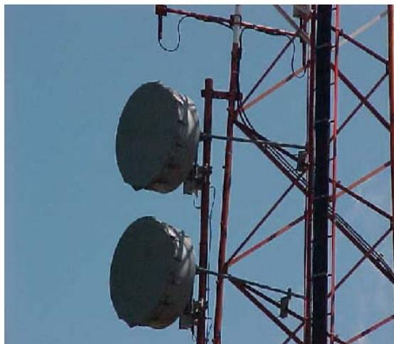
**Figura A.3.8** Antenas para transmisión por microondas en estación base Colima.
