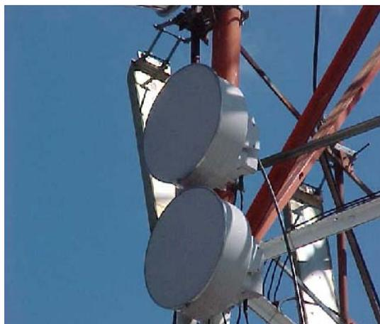
**Figura A.3.20** Antenas para transmisión por microondas en estación base San Pedro.
