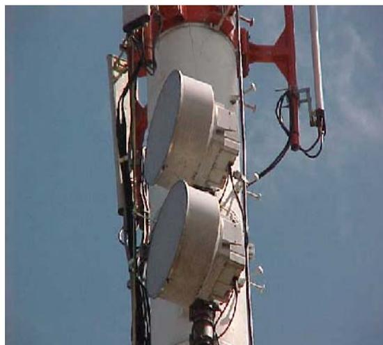
**Figura A.3.12** Antenas para transmisión por microondas en estación base González Víquez.
