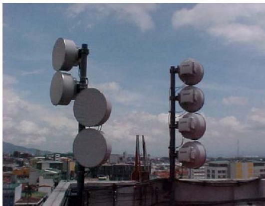
**Figura A.3.2** Antenas para transmisión por microondas en estación base central San José.
