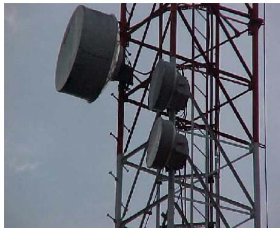
**Figura A.3.6** Antenas para transmisión por microondas en estación base Paseo Colón.
