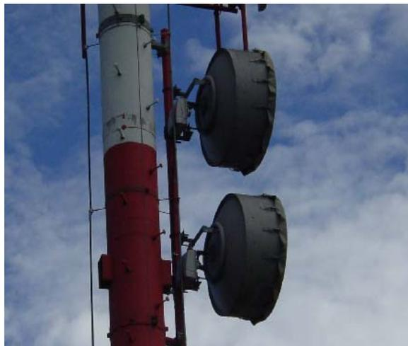
**Figura A.3.10** Antenas para transmisión por microondas en estación base Zapote.
