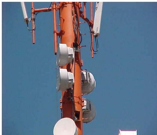
**Figura A.3.14** Antenas para transmisión por microondas en estación base González Víquez.
