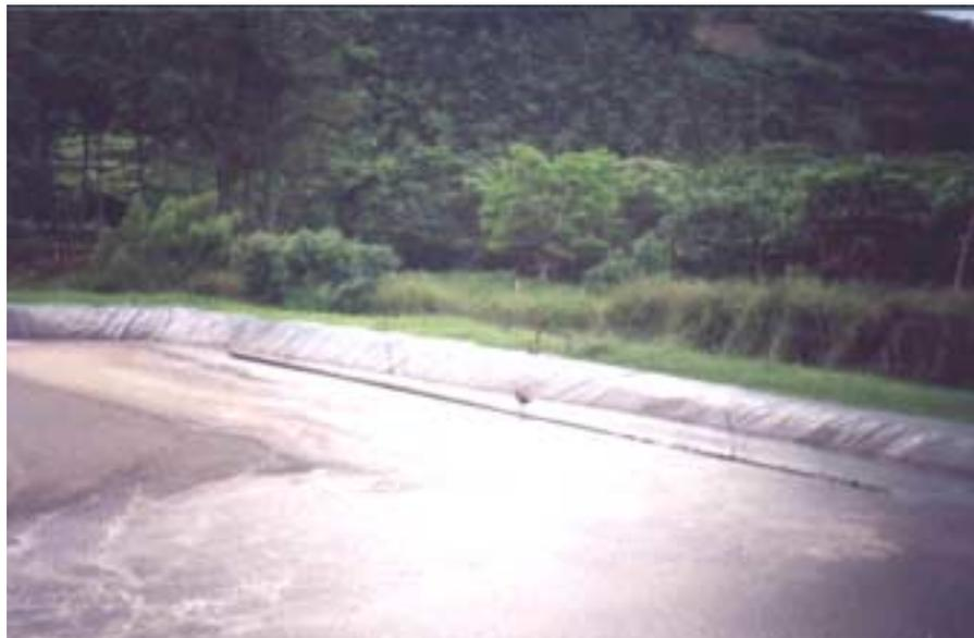
**Figura 6.** Laguna de oxidación anaerobia.
