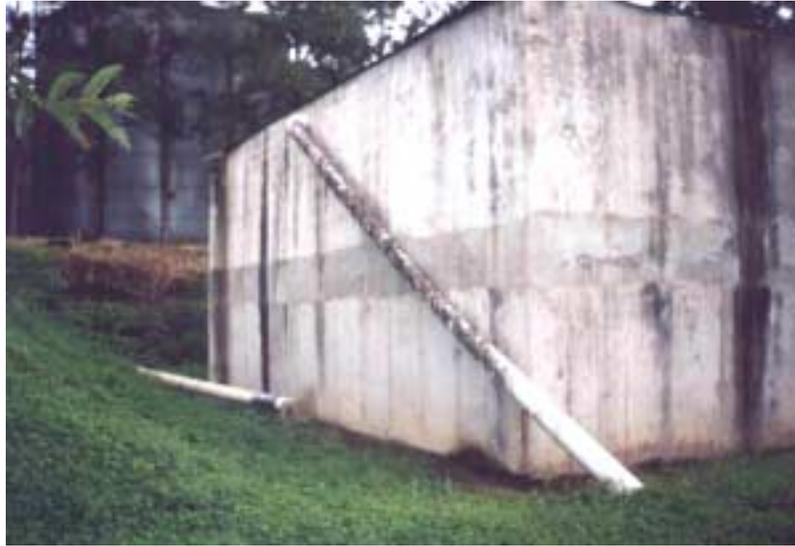
**Figura 3.** Filtro anaerobio de flujo ascendente.
