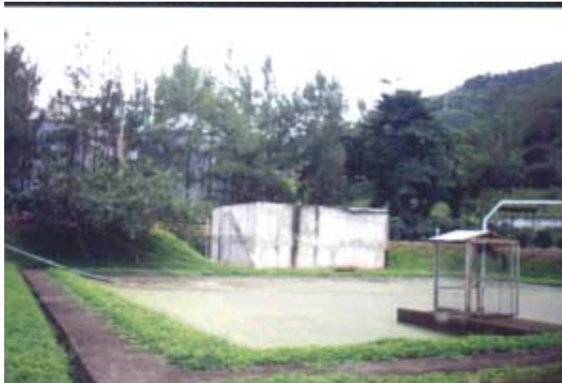
**Figura 4.** Filtro anaerobio (al fondo) y laguna de lodos.
