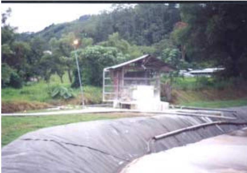
**Figura 5.** Segundo dosificador de cal ubicado a la entrada de la laguna de oxidación.
