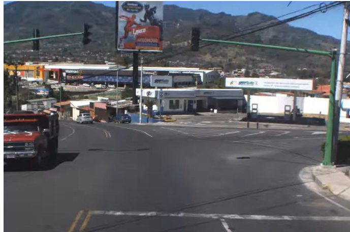
Semáforo con problemas de funcionamiento
