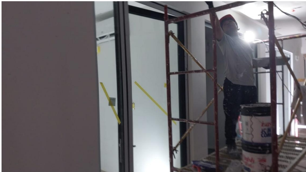
Figura 19. Operario empaste cielos livianos
