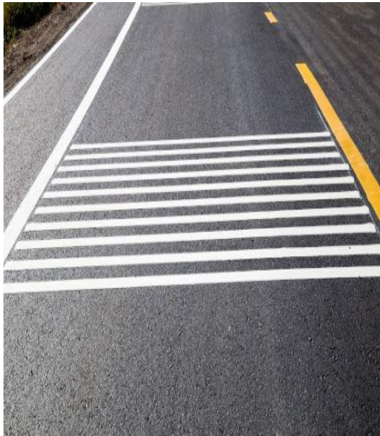
Figura 38. Bandas alertadoras en la vía
