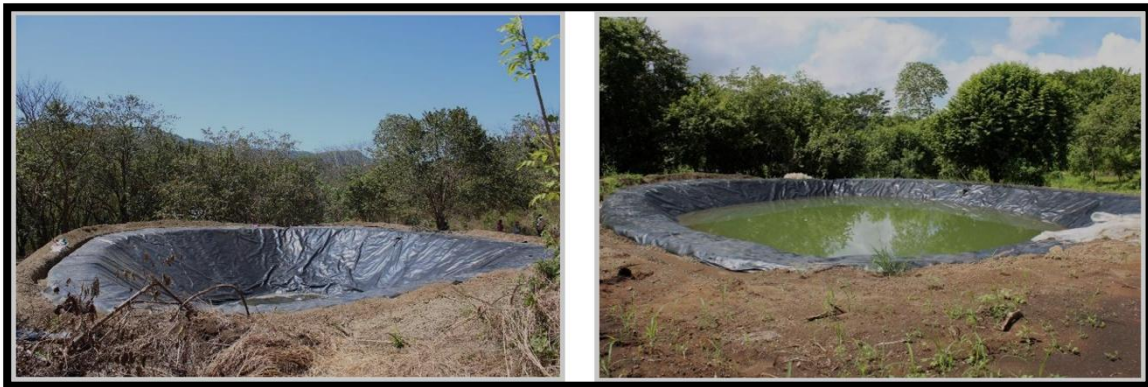
Figura 32. Reservorio de 500 m 3 y 400 m de espejo de agua. Fuente: Cortesía CEMEDE, UNA.
