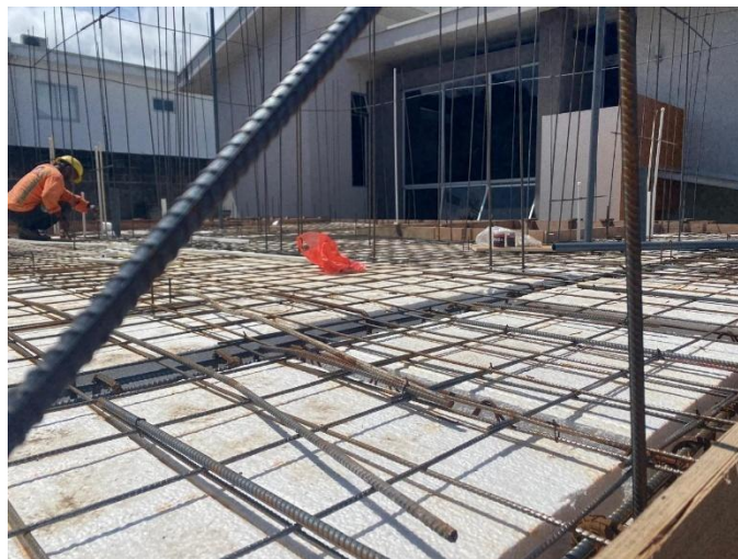
Figura 25. Procesos de confección de armadura para entrepiso.
