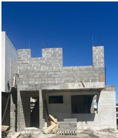
Figura 27. Ejemplo de paredes del segundo nivel terminadas.
