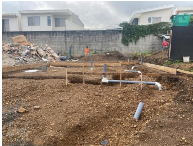
Figura 19. Procesos de excavación e instalación de tubería mecánica-sanitaria
