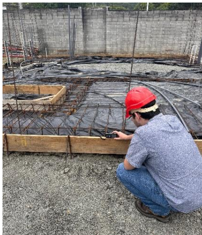
Figura 51. Revisión de la formaleta de las cimentaciones de la vivienda 3.
