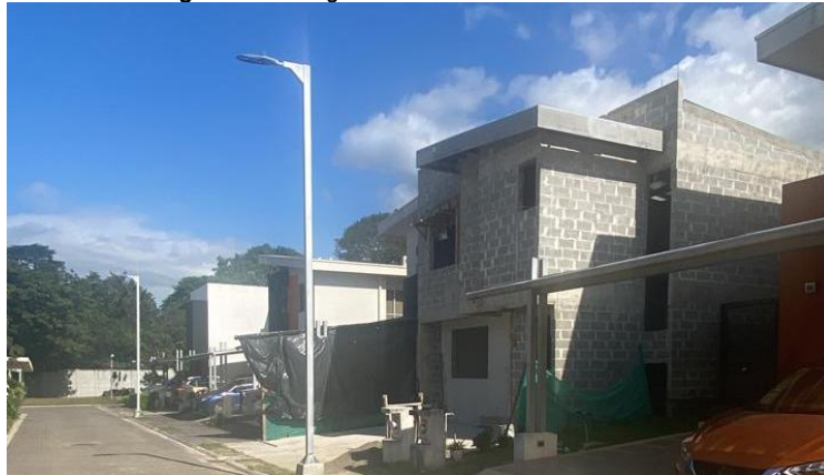
Figura 1. Vista general del condominio Río Plata.
