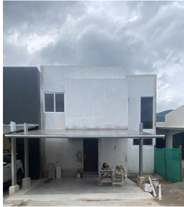
Figura 34. Proceso de techado de garaje.
