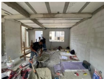
Figura 33. Proceso de repello de paredes internas.
