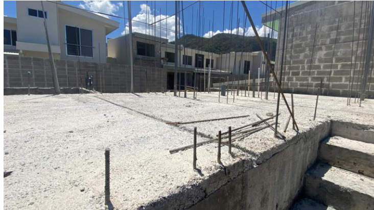
Figura 26. Losa de entepiso colada.
