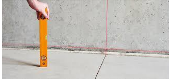
Figura 13. Revisión del nivelado de una superficie
