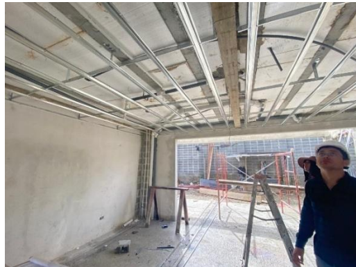
Figura 35. Instalación de estructura de cielo y sistema eléctrico.
