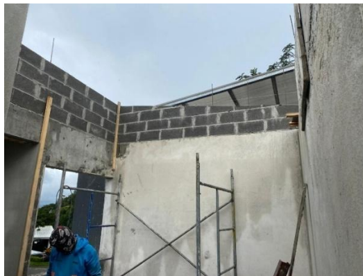
Figura 29. Pega de bloques para el tapichel.
