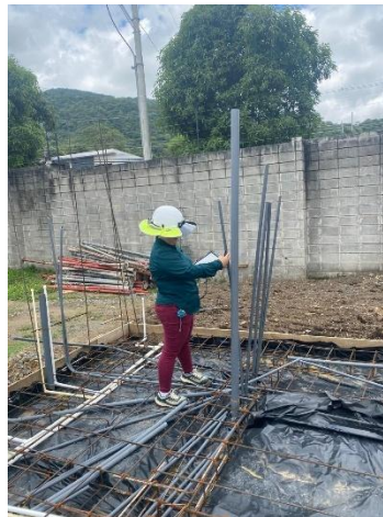
Figura 53. Ingeniera residente participando en la revisión de la armadura de la cimentación de la vivienda 3..
