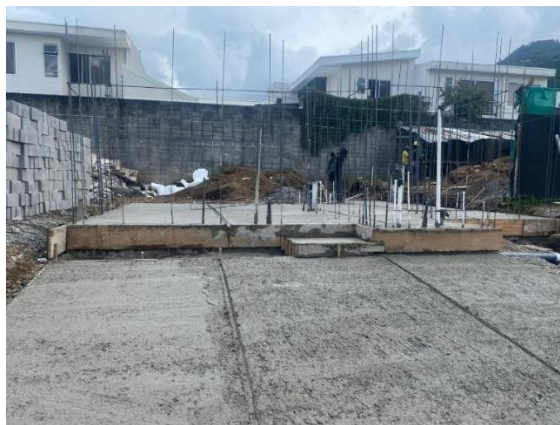
Figura 21. Colado de losa de contrapiso.
