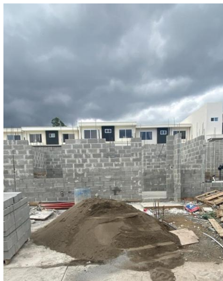
Figura 23. Etapa de paredes del primer nivel finalizada.
