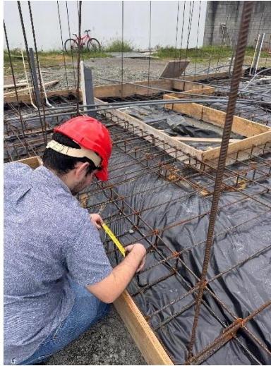
Figura 52. Revisión de armadura de placa corrida de la vivienda 3.
