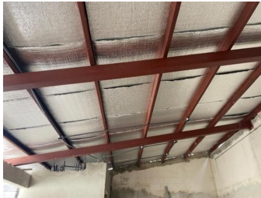
Figura 31. Estructura instalada junto con aislante y cubierta.
