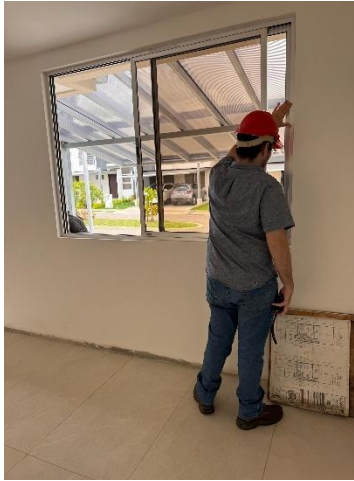
Figura 67. Revisión de las ventanas de la vivienda 55.
