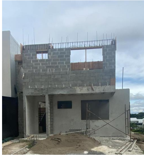
Figura 28. Instalación de armadura de viga corona y encofrado.
