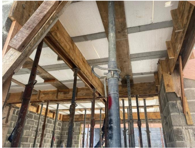
Figura 24. Cargadores y puntales para soporte del entrepiso.
