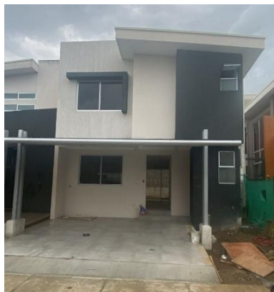
Figura 65. Vista general de la obra de la vivienda 55.
