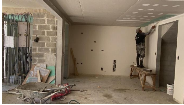
Figura 36. Instalación de láminas de cielo
