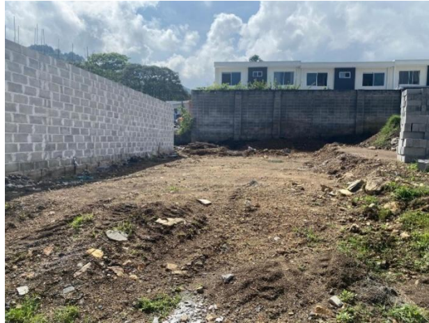
Figura 18. Proceso de nivelación y compactación del terreno
