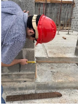
Figura 59. Revisión del relleno entre bloques de la pared de la vivienda 27.
