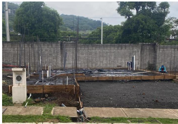
Figura 50. Vista general de la obra de la vivienda 3.
