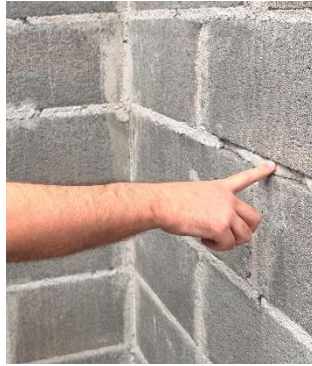
Figura 59. Revisión del relleno entre bloques de la pared de la vivienda 27.
