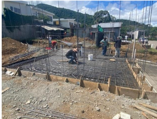
Figura 21. Colado de losa de contrapiso.
