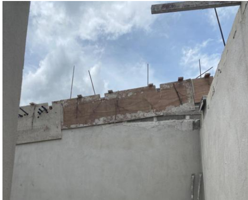
Figura 30. Encofrado de viga tapichel.
