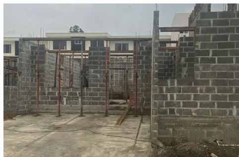
Figura 57. Vista general de la obra de la vivienda 27.
