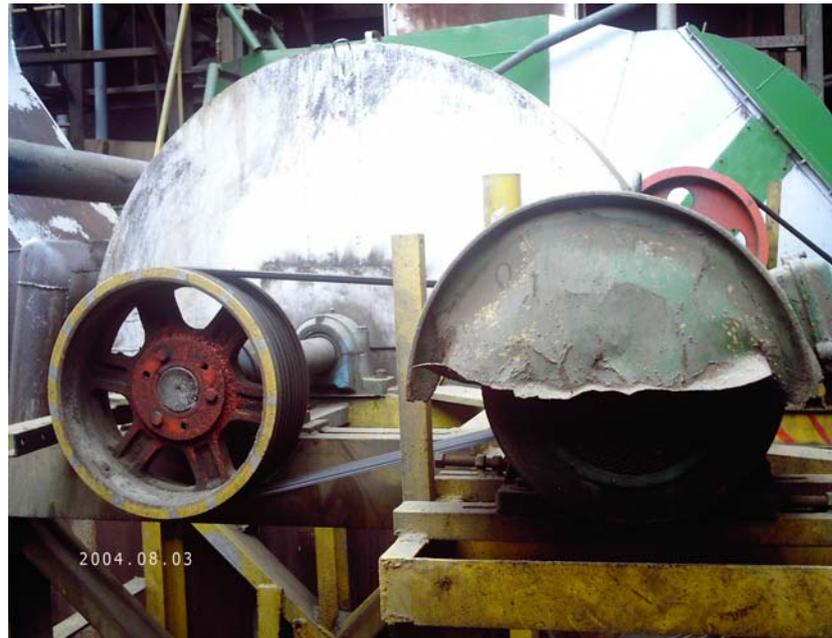
Figura C 1.9 Motor Abanico Tiro Inducido Caldera 1
