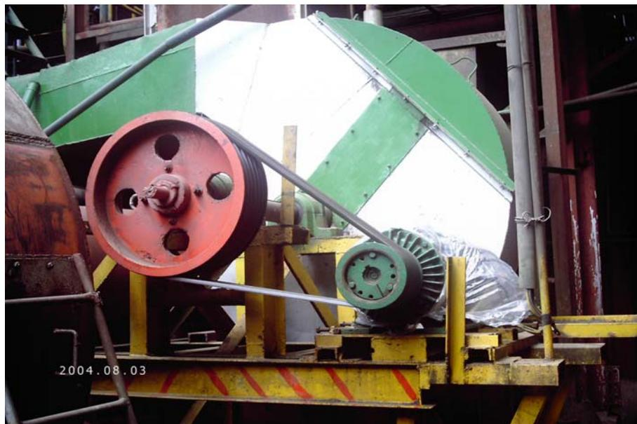
Figura C 1.7 Motor Abanico Tiro Forzado Caldera 1
