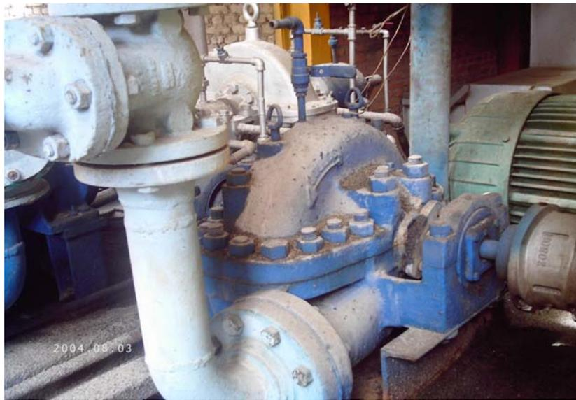
Figura C 1.4 Bomba B2 Goulds 300 GPM
