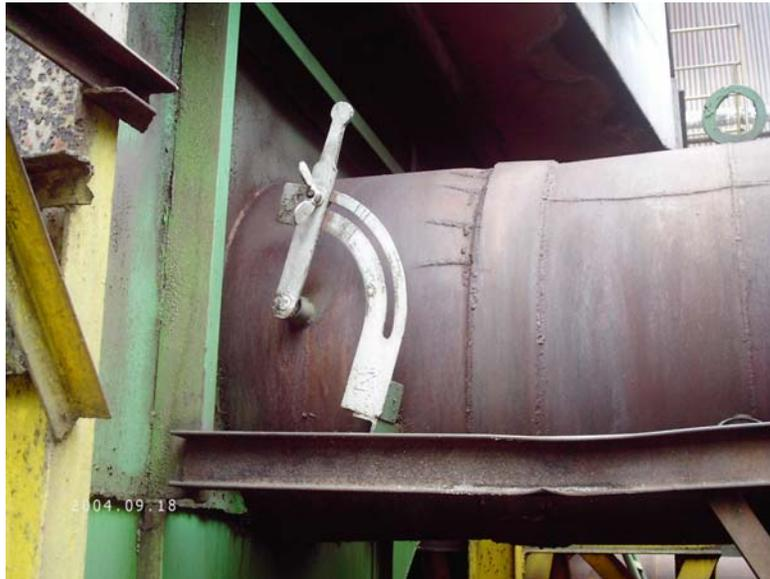
Figura 5.6 Calibración actual del damper abanico de tiro inducido Caldera 1 Babcock & Wilcox tubos curvos Ingenio San Ramón
