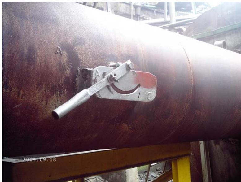
Figura 5.7 Calibración actual del damper abanico de tiro inducido Caldera 2 Babcock & Wilcox tubos rectos Ingenio San Ramón
