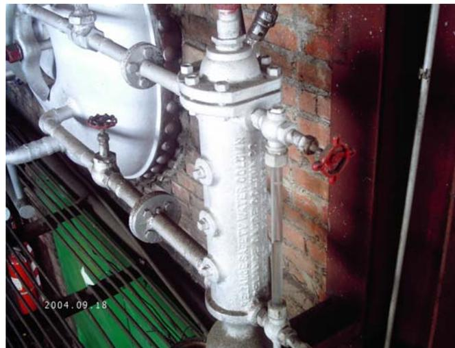
Figura 5.3 Control del nivel de agua Caldera 2 Babcock & Wilcox
