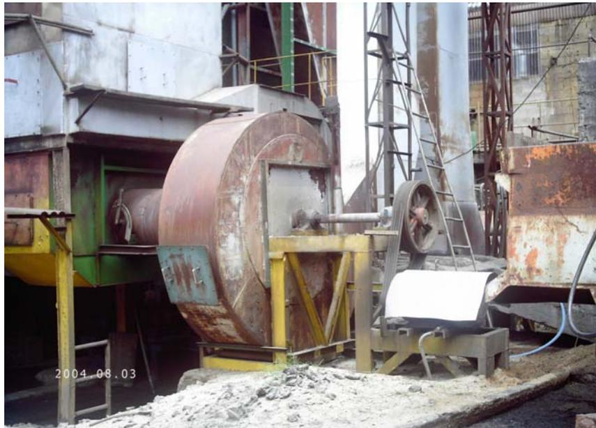
Figura C 1.10 Motor Abanico Tiro Inducido Caldera 2
