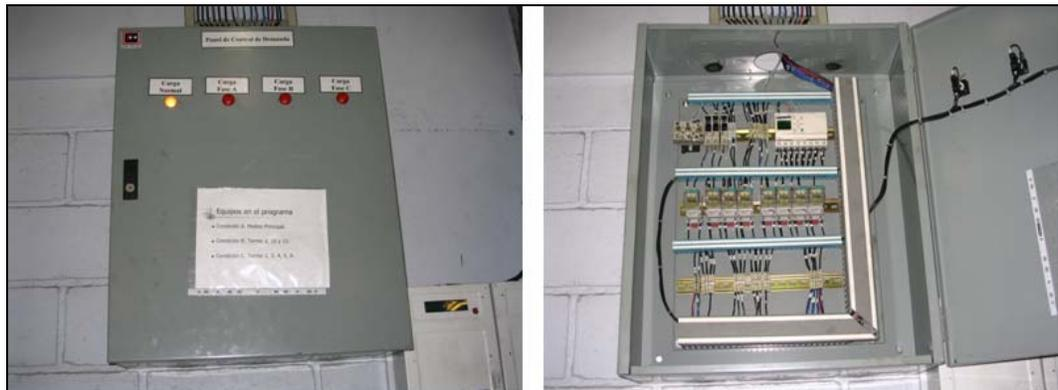
**Figura 6.3** Conjunto de contactores para la desconexión de cargas no significativas
