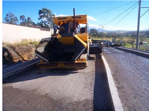
Figura 30. Pavimentadora (vista frontal).
