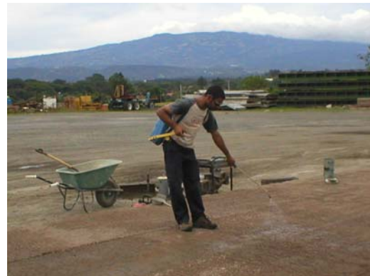
Figura 34. Curado de la superficie del concreto con membrana de cura.
