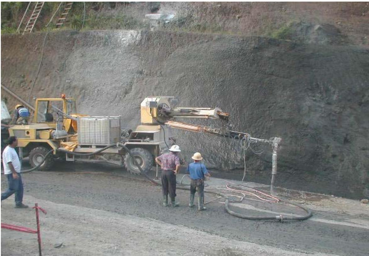
**Figura 3.** Colocación de concreto lanzado.
