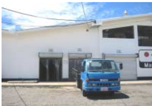
Fotografía 2: Zona de carga
