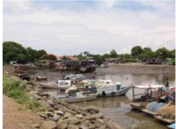
Fotografía 9: Vista general de sector oeste de la terminal
