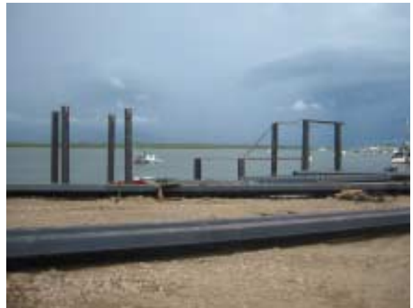
Fotografía 7: Terminal de transbordadores en construcción
