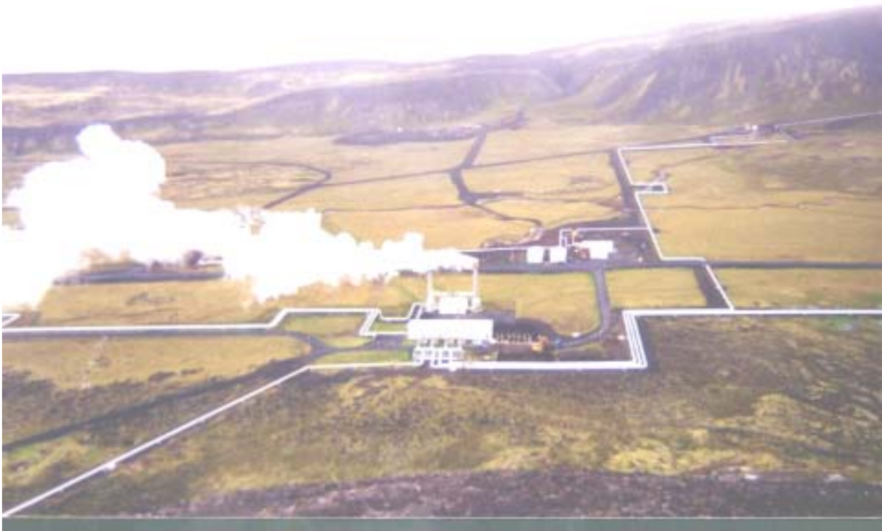
Figura 7 Campo Geotérmico en Islandia. Nótese el sistema de conducción de los fluidos y las omegas. (Imagen JPG).
