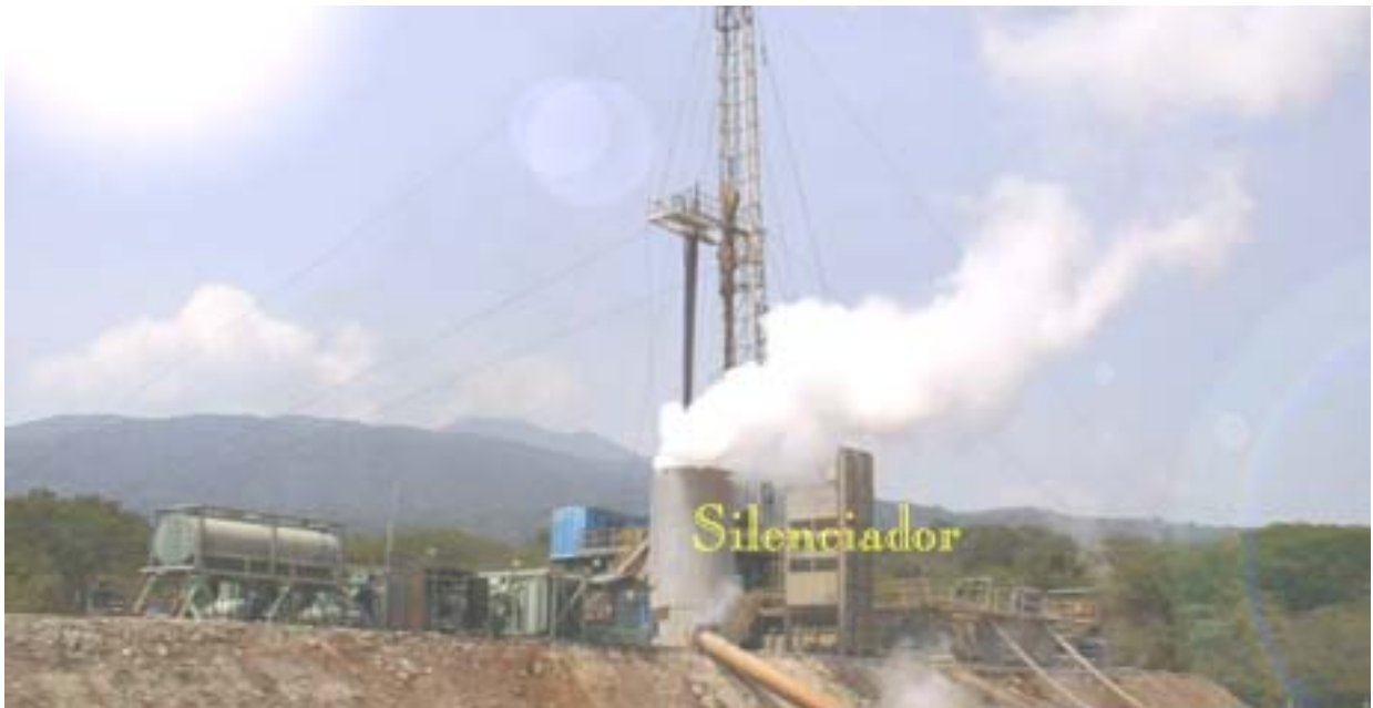
Figura 24 Torre de perforación. Apertura durante prueba de producción. (Imagen JPG).
