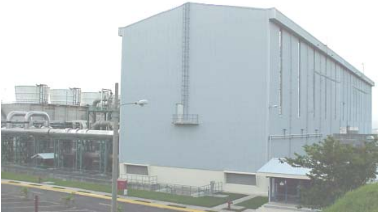
Figura 12 Casa de Máquinas. En el plano izquierdo puede apreciarse las torres de enfriamiento y el sistema de conducción del vapor procedente de las unidades de separación. (Imagen JPG).
