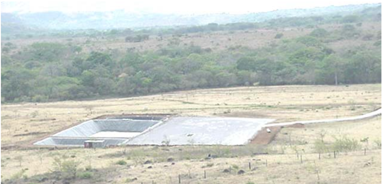
Figura 16 Plazoleta. Puede apreciarse la plataforma las tres lagunas. Nótese el contrapozo en el centro de la plazoleta y los caminos de acceso. (Imagen JPG).
