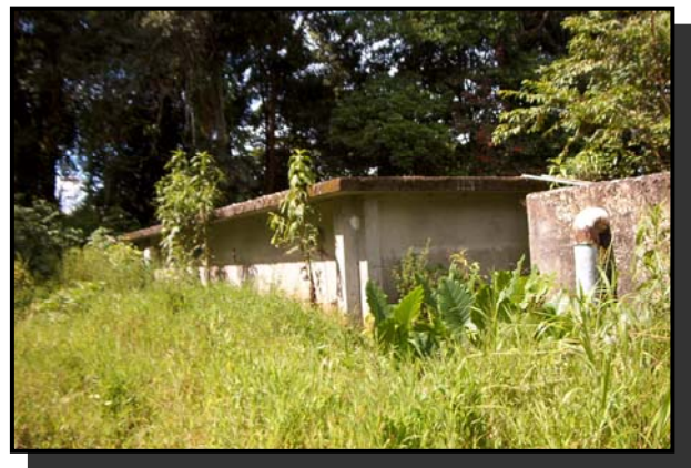
Foto 5 Tanques de almacenamiento para la comunidad de La Guaria, Volúmenes de almacenamiento 150m 3 y 300m 3 .
