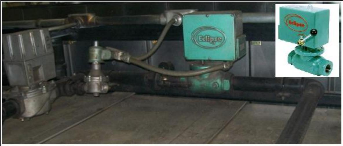
**Ilustración 3.3** Válvula de seguridad
