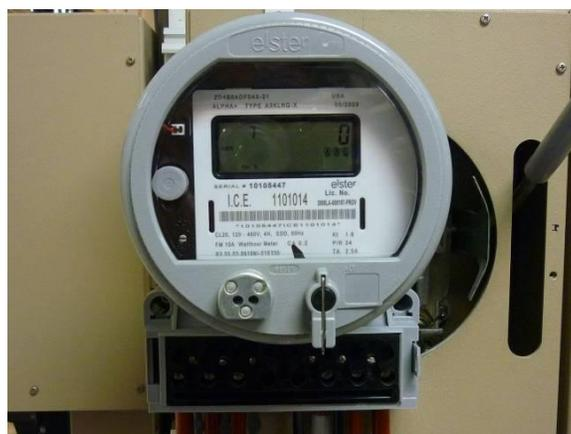
**Figura 5.15** Medidor Alpha A3 de Elster
