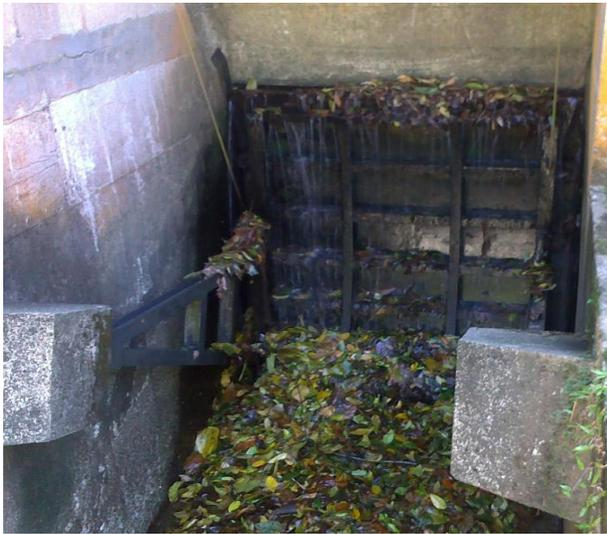
**Figura 5.30.** Compuerta de descarga de fondo R1.
