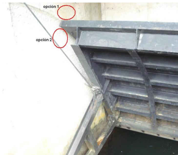
**Figura 5.25.** Posibles ubicaciones de los sensores en la compuerta R2.
