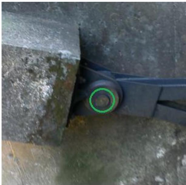
**Figura 5.27.** Eje de R1 que gira junto con la compuerta.
