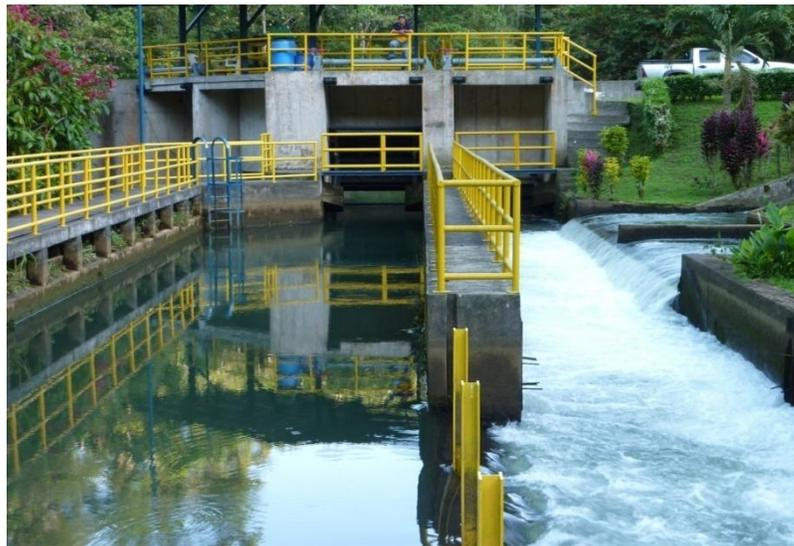
**Figura 3.2.** Toma de agua de la Central Hidroeléctrica Platanar; a la izquierda se aprecia el desarenador.
