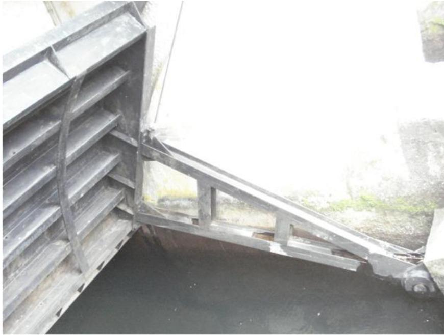
**Figura 5.35.** Compuerta al desarenador (R2).
