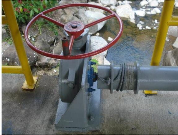
**Figura 1.1.** Manivela para abrir la compuerta R1.
