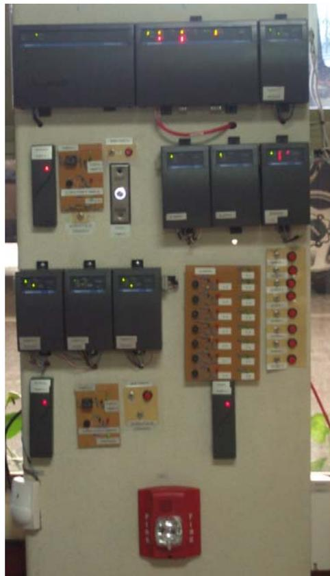
Figura 6.1 Módulo de pruebas del sistema integral de seguridad.
