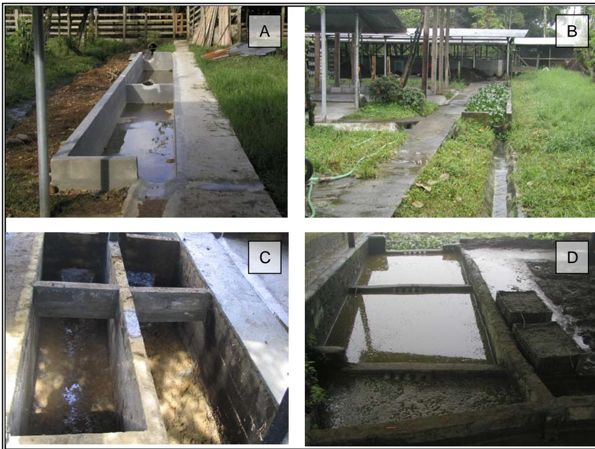
Figura 5. Tecnologías implementadas para el tratamiento de las aguas residuales, la Coneja y San Isidro, 2004. A) Estructura básica de pila de tratamiento independiente, B) Pila de tratamiento independiente con lirios cultivados, C) Estructura para la parte de maduración de los sólidos, D) Pilas anexas para tratamiento de las aguas residuales.
