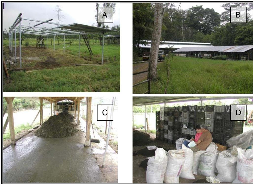
*Figura 3. Infraestructura para maduración aeróbica de los desechos sólidos orgánicos. A) Construcción con hierro galvanizado en una sola agua, B) Construcción con armadura de madera y techo de zinc a dos aguas, C) Piso de concreto quemado con drenaje para los lixiviados y D) Vista de la altura menor*
