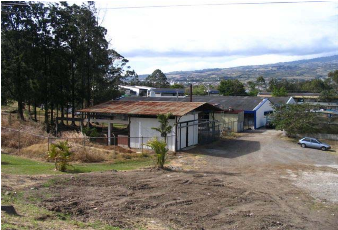
FIGURA 5. LABORATORIO DE DESECHOS PELIGROSOS DEL ITCR.
