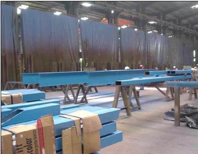
Figura 3.5. Área de Pintura
