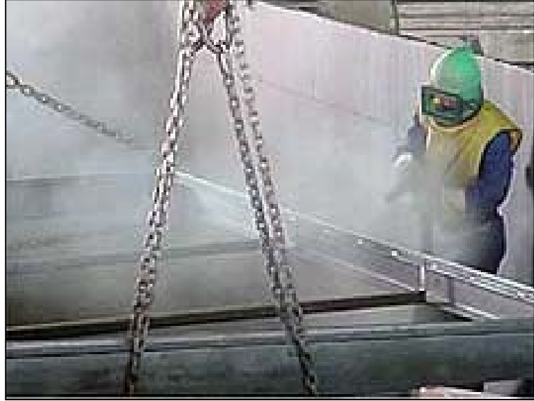
Figura 3.6. Área de Limpieza (Sandblasting)
