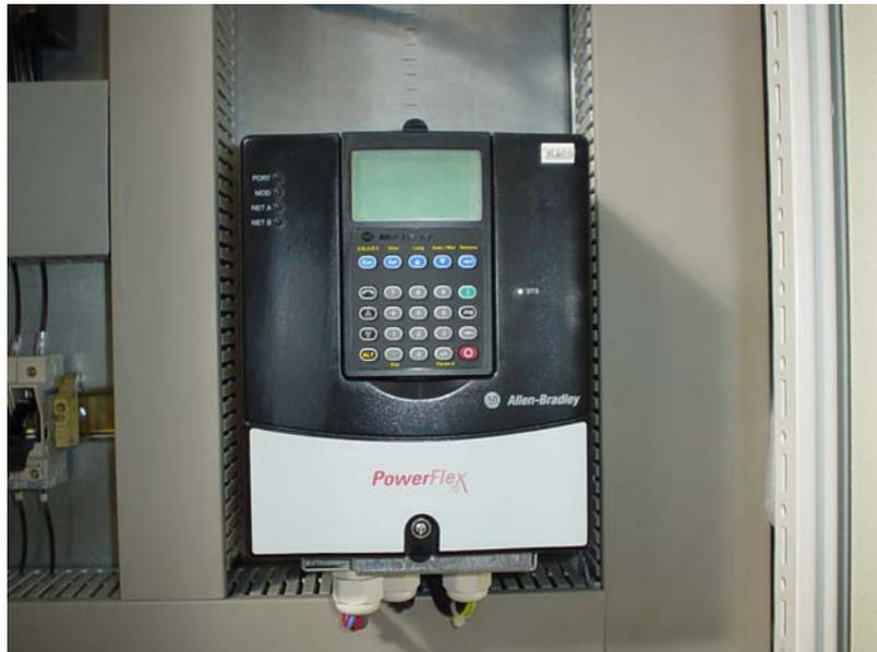
Figura A.4. 2 Fotografía de variador de frecuencia PowerFlex 70
