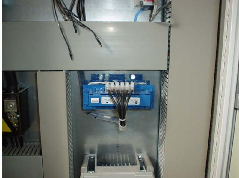
Figura A.4. 3 Fotografía de reactor de línea trifásico utilizado para el variador
