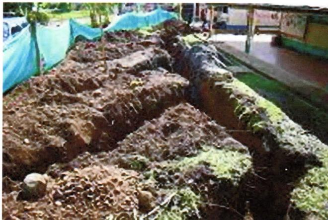
**Fig. 11** Excavaciones para drenajes
