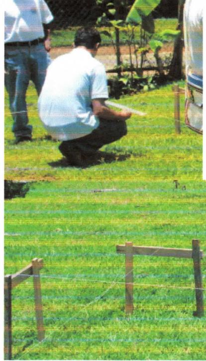
**Figura 1.4 Colocación de Yuguetas, esquinas.**
