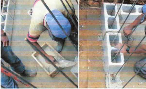
**Figura 2.3 Colocación de un bloque en sitio.**
