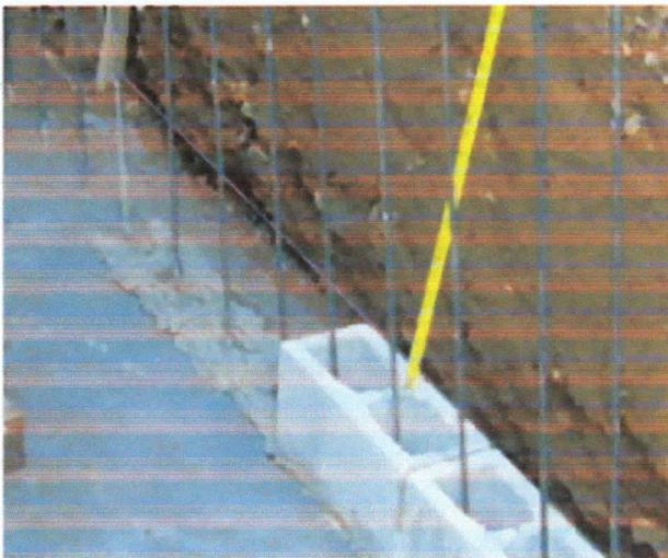
**Figura 2.21. Colocación de acero vertical.**
