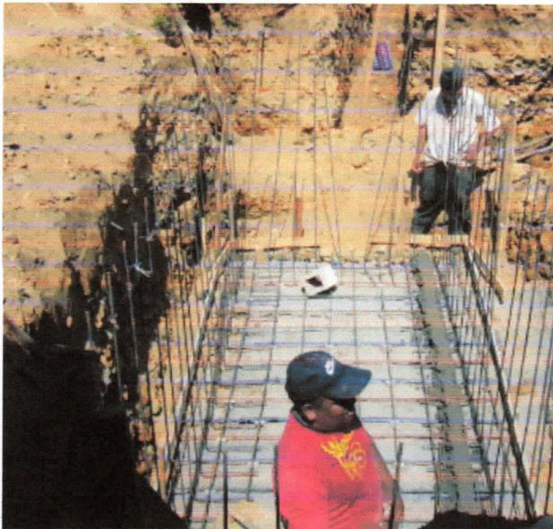
Figura 3.7. Colocación de acero vertical antes de chorrear la losa de piso.
