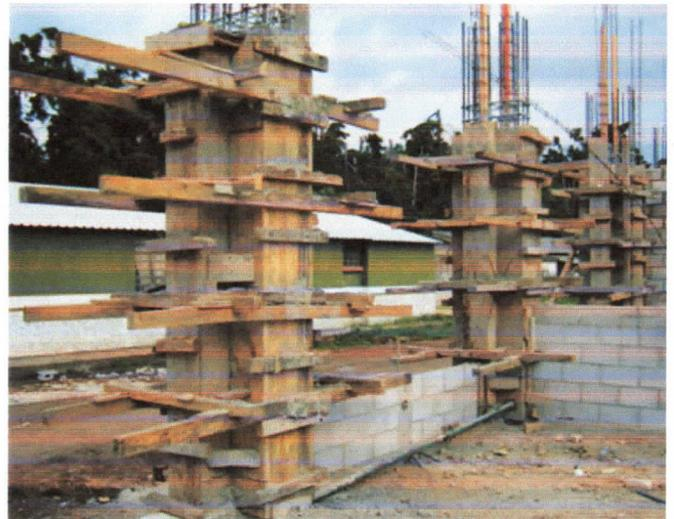
*Figura 4.2. Formaletas de madera en columnas.*
