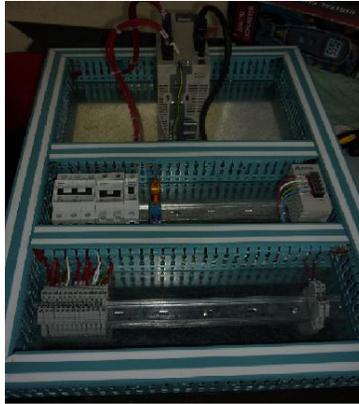
**Figura 5.14.** Tablero eléctrico del servo control.
