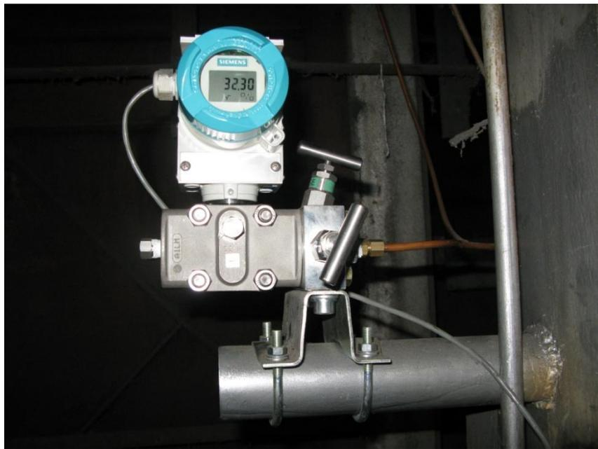
**Figura 6.1.2** Fotografía del transmisor de presión diferencial instalado.
