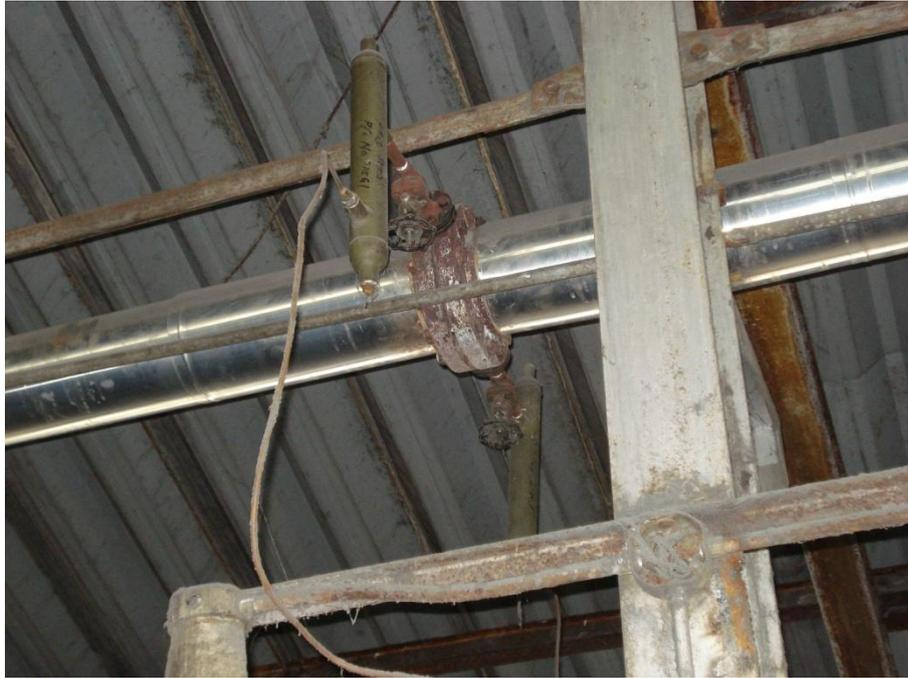
**Figura 5.2.1** Placa de orificio en la tubería de salida de la caldera
