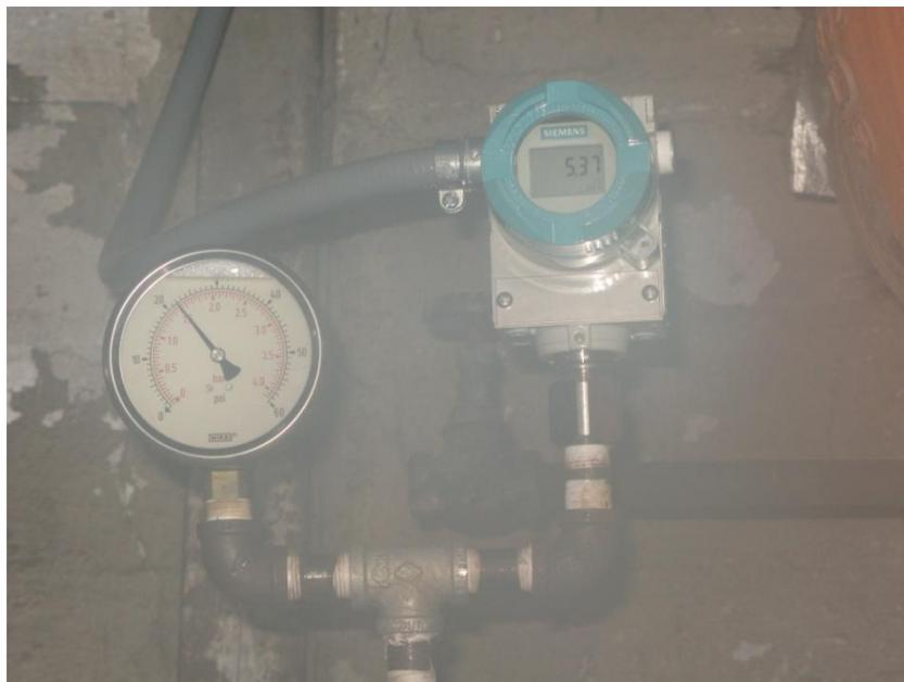
**Figura 6.1.3** Fotografía del transmisor de presión manométrica instalado en el cilindro distribuidor
