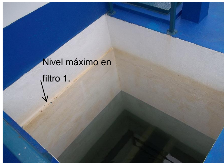
Figura A.29 Ilustración de nivel máximo en filtros. Fuente Elaboración Propia.
