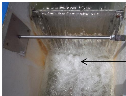
Figura A.16 Fotografía cámara de entrada, agua después del vertedero. Fuente Elaboración Propia.
