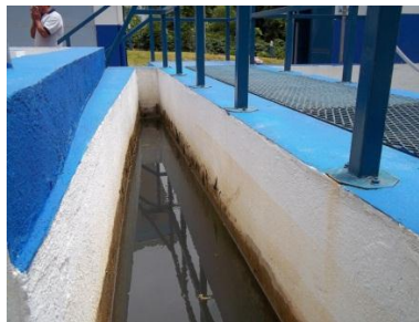
Figura A.36 Zona de salida de la cámara de floculación. Fuente Elaboración Propia.
