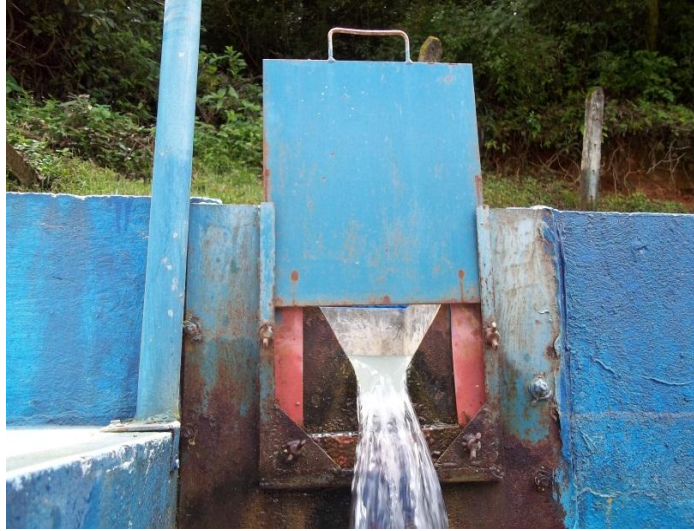
Figura A.38. Vertederos de la cámara de entrada hacia filtro grueso de flujo horizontal. Fuente Elaboración Propia.
