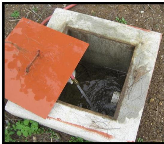
**Figura 4.1. Prueba hidrostática, llenado con agua potable de la planta de lodos activados.**
