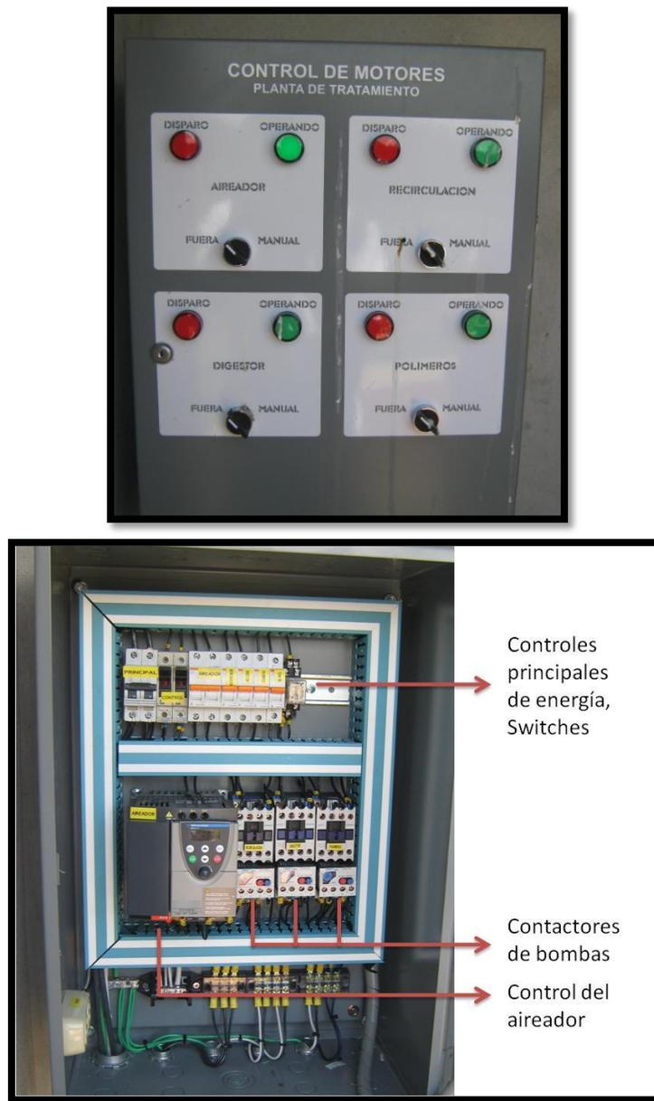
**Figura 3.3. Panel de control. Arriba: Carátula del panel. Abajo: Componentes del panel de control.**
