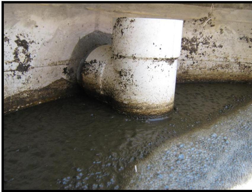
**Figura 5.1. Espuma en el tanque de aireación.**
