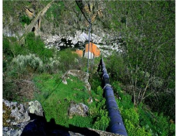
**Figura 10.** Tubería de presión
