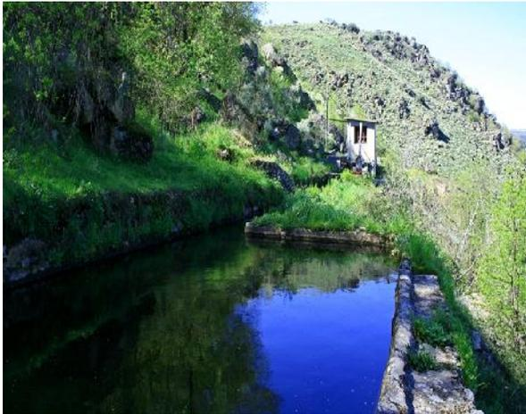
**Figura 9.** Cámara o tanque de carga
