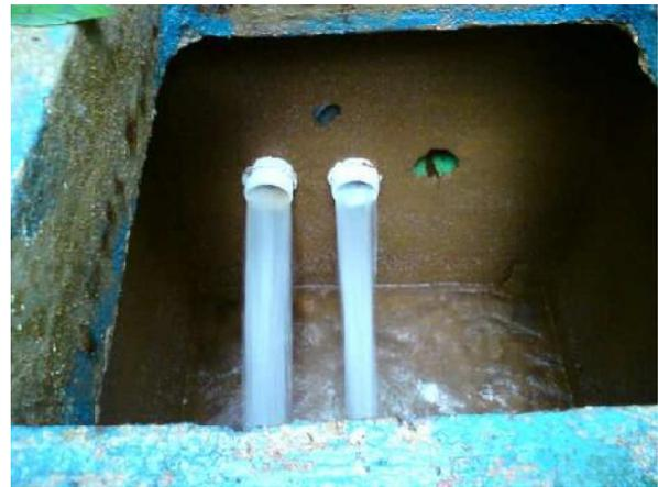
Figura 28. Tubos de entrada en el segundo tanque de Reunión
