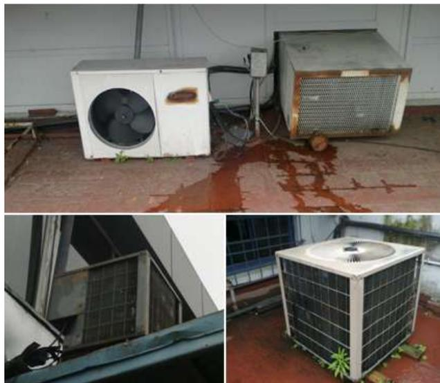
Figura 15. Ejemplo del estado de varios aires acondicionados utilizados en Bancrédito.
