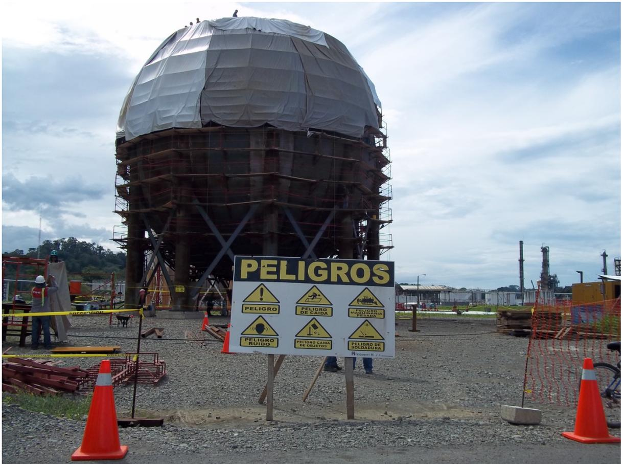
**Figura 3.26** Ejemplo de señalización en el área de construcción de la esfera YT-7711
