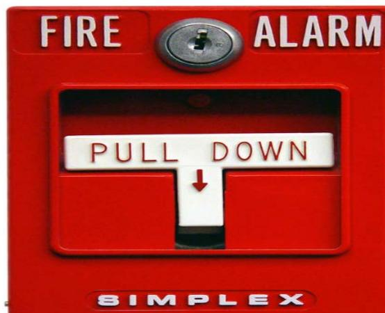
Figura 5.18 Estación manual del sistema contra incendio
