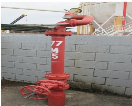
**Figura 5.38** Lanza de agua utilizada en las instalaciones de RECOPE
