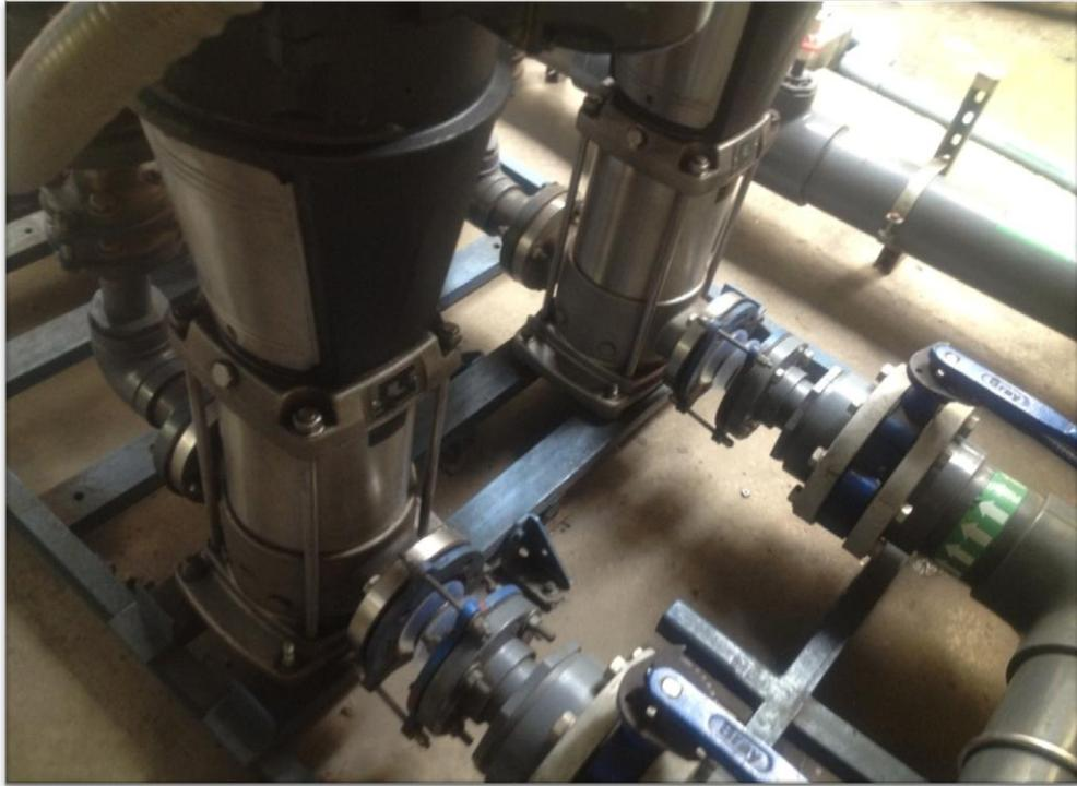
**Figura 3.1.2** Bombas de Inyección de Agua Ultra Pura para Piso de Producción (Fotografía)
