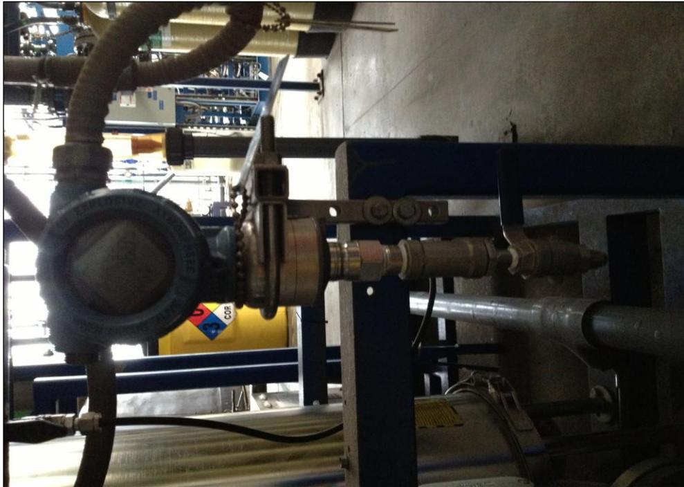
**Figura 3.1.3** Sensor y transmisor de presión (Fotografía)
