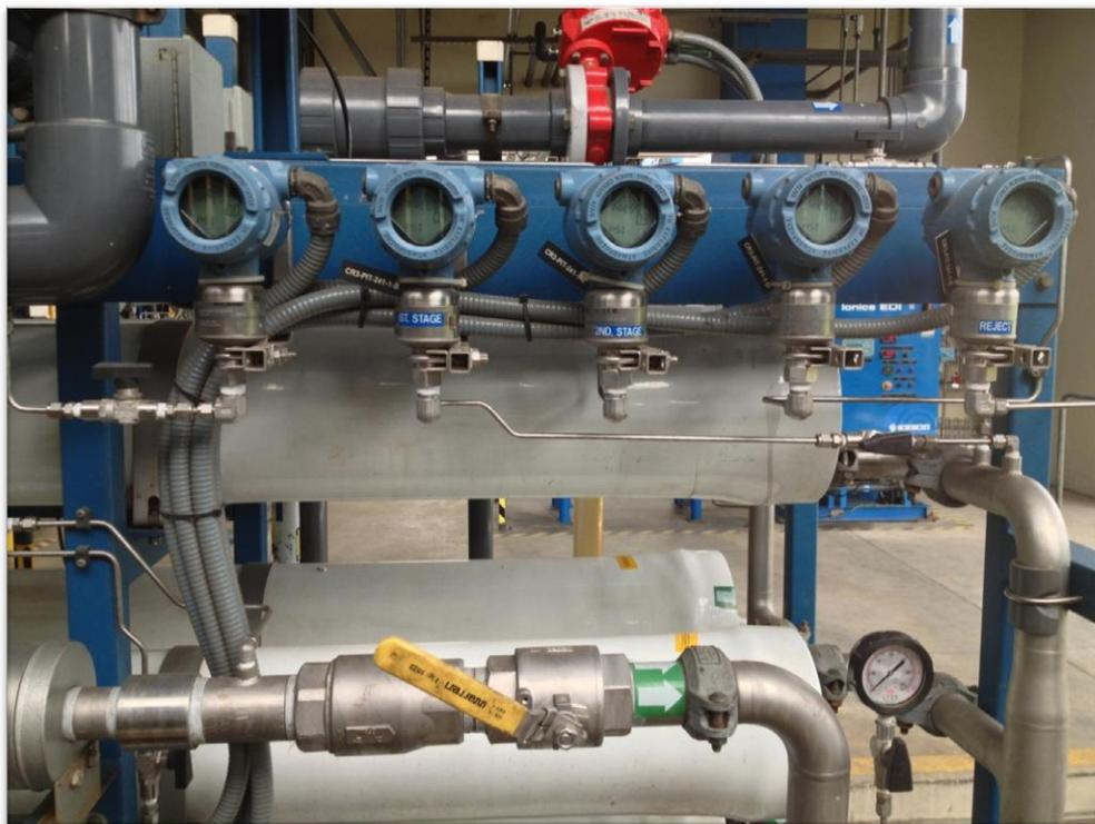
**Figura 3.3.1** Sensores de Presión en Operación con Conexión de Tubo de Acero Inoxidable de  $\frac{3}{4}$  de Pulgada (Fotografía)
