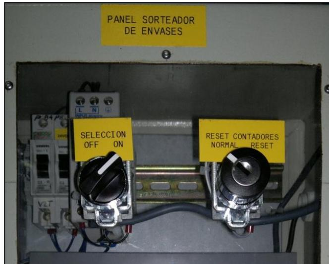
**Figura 5.26:** Interruptor de Selección de Encendido del Sistema (SELECCIÓN) y Reset de Contadores del sistema en el Panel Principal del Sorteador de Envases.
