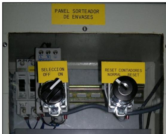
**Figura A.2.2:** Interruptor de Selección de Encendido del Sistema (SELECCIÓN) y Reset de Contadores del sistema en el Panel Principal del Sorteador de Envases.
