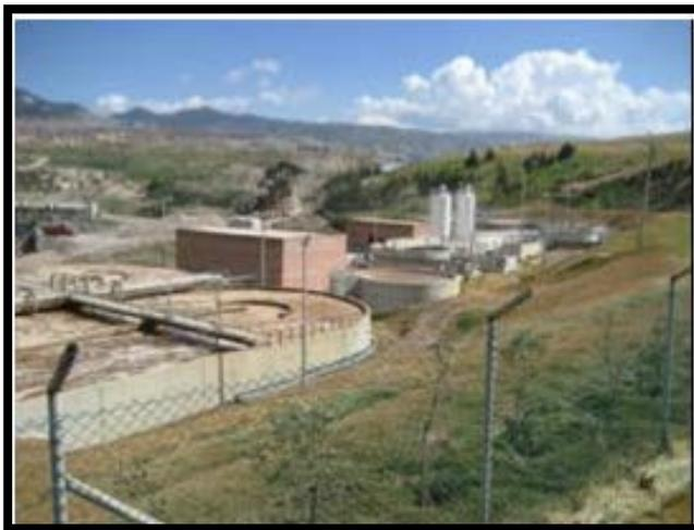
**Figura 17. Sistema de tratamiento de lixiviados del relleno sanitario Doña Juana**
