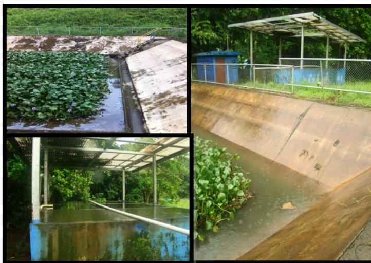
**Figura 7. Tanque de almacenamiento de lixiviados : diferencia en los niveles de lixiviados estación lluviosa y seca**
