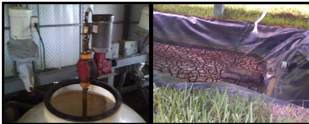
**Figura 16. Dispensador de coagulante y lecho de secado**
