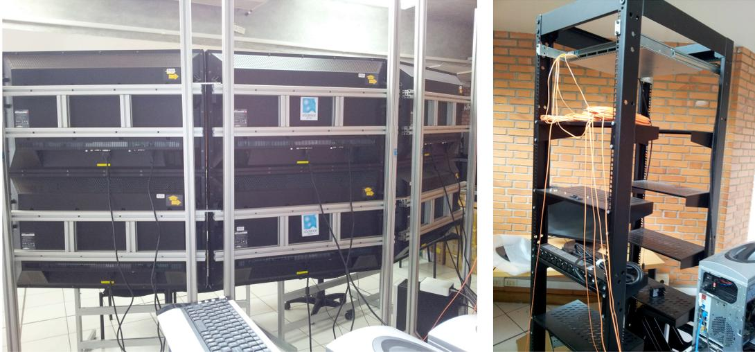
Fig. 22. Perfiles metálicos que soportan los monitores instalados y Rack para contener las computadoras y el switch instalado
