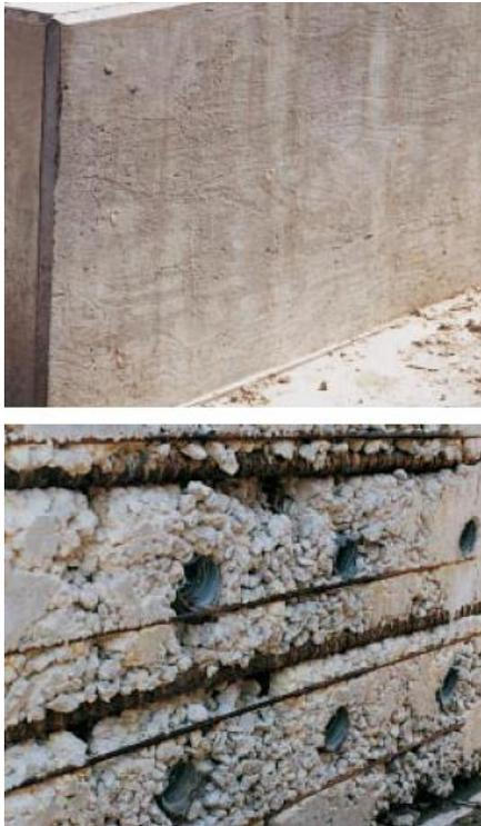
**Figura 3.** Concreto con buena compactación (superior) concreto con compactación pobre (inferior).<sup>12</sup>
