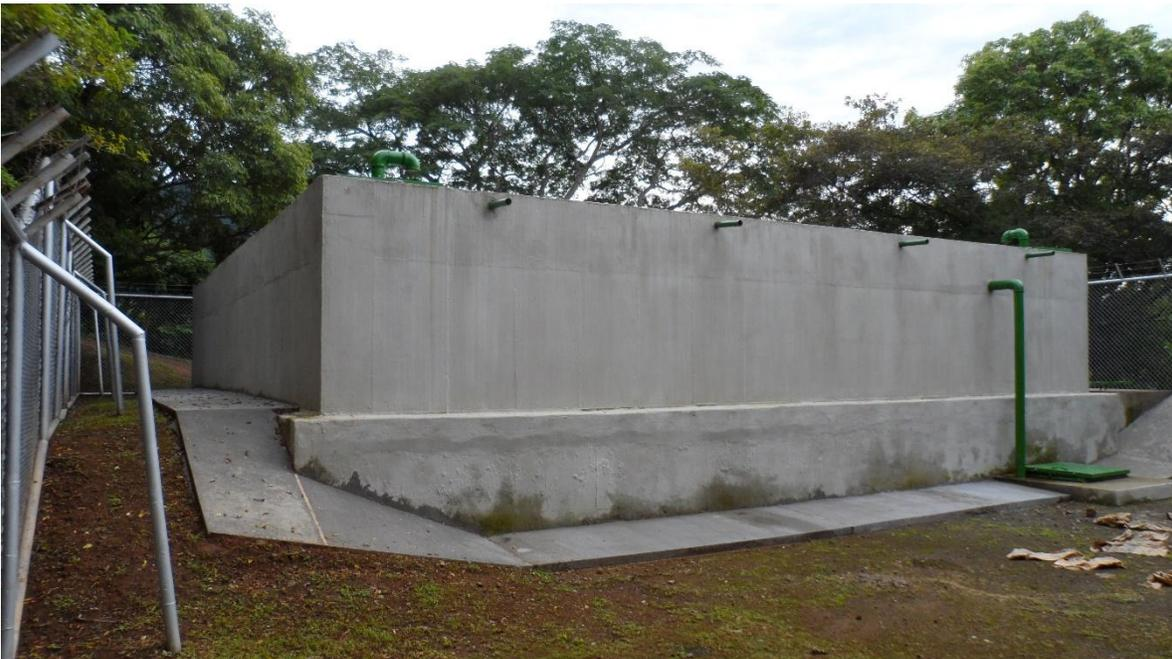
Fotografía 4. Vista posterior del tanque, se observa la tubería de rebalses
