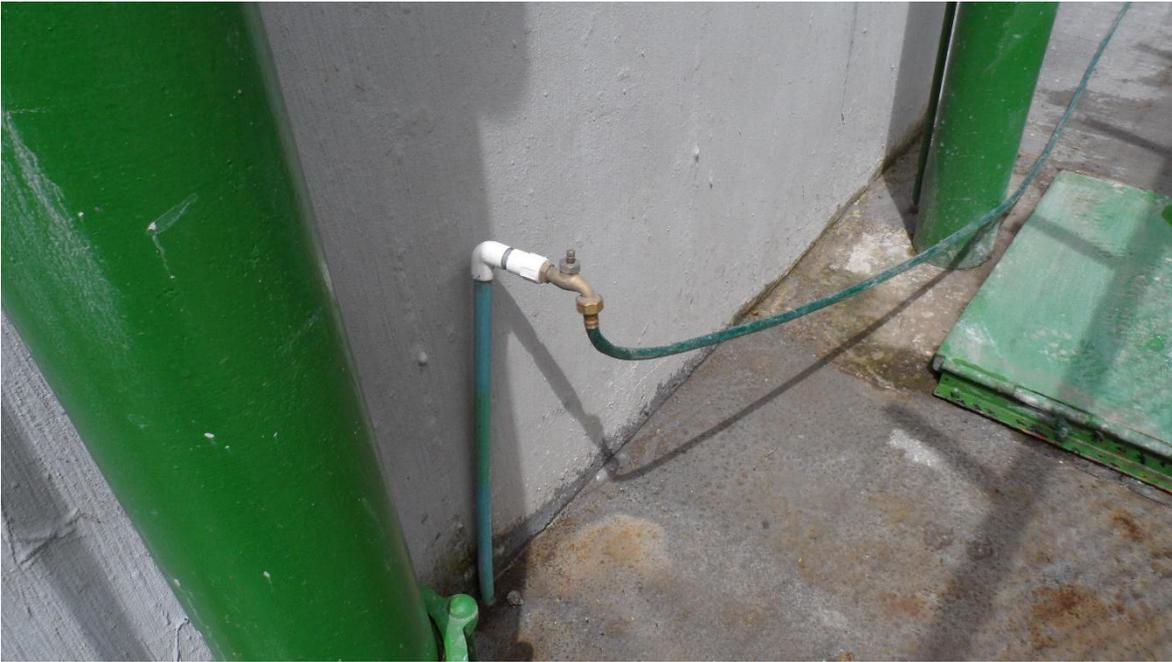
Fotografía 6. Tubo de muestreo a la entrada del tanque.
