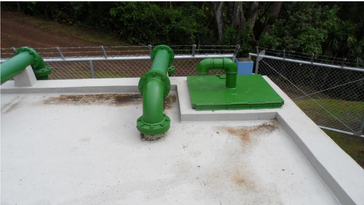
Fotografía 2. Tubería de entrada al tanque y respiradero
