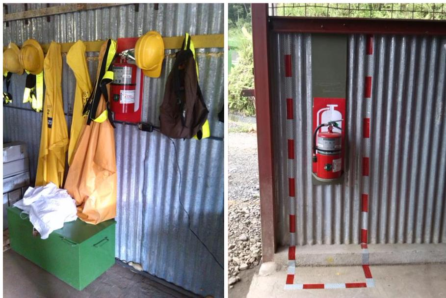
Figura 23. Antes y después de la ubicación del extintor en la bodega
