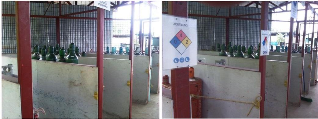
Figura 43. Antes y después de colocar los rombos en la bodega de cilindros.
