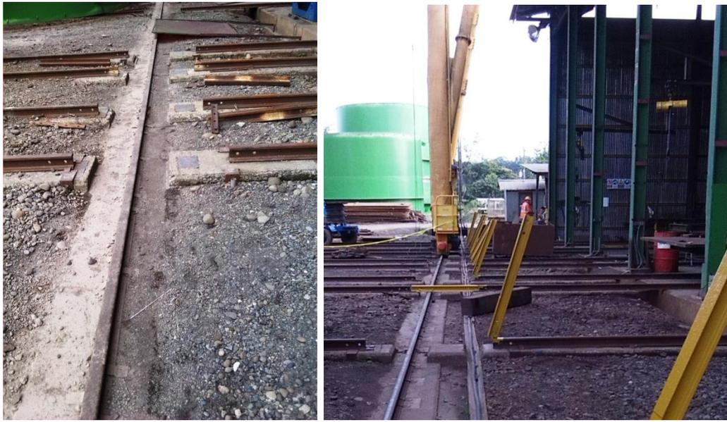
Figura 28. Antes y después de las intersecciones en los rieles
