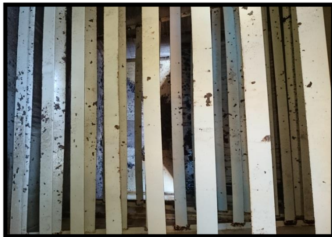
Figura 4.15 Relleno de la actual torre de enfriamiento.
