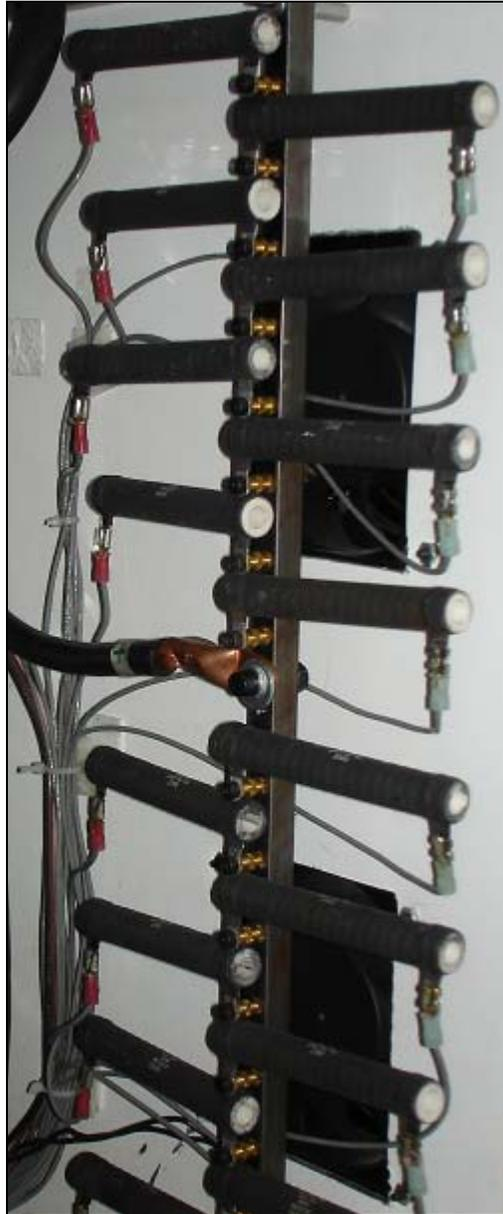
**Figura 6.2** Ensamble de resistencias de carga
