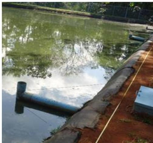
**Figura 3.2.5. Estructuras de salida de la laguna**
