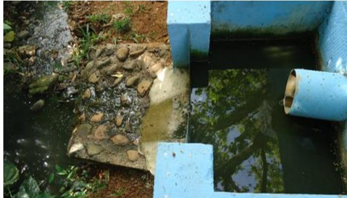
Figura 3.2.6. Estructura de salida de la PTAR
