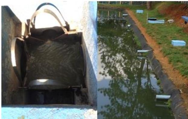
**Figura 3.2.3. Sistema de distribución del caudal de entrada a la laguna.**
