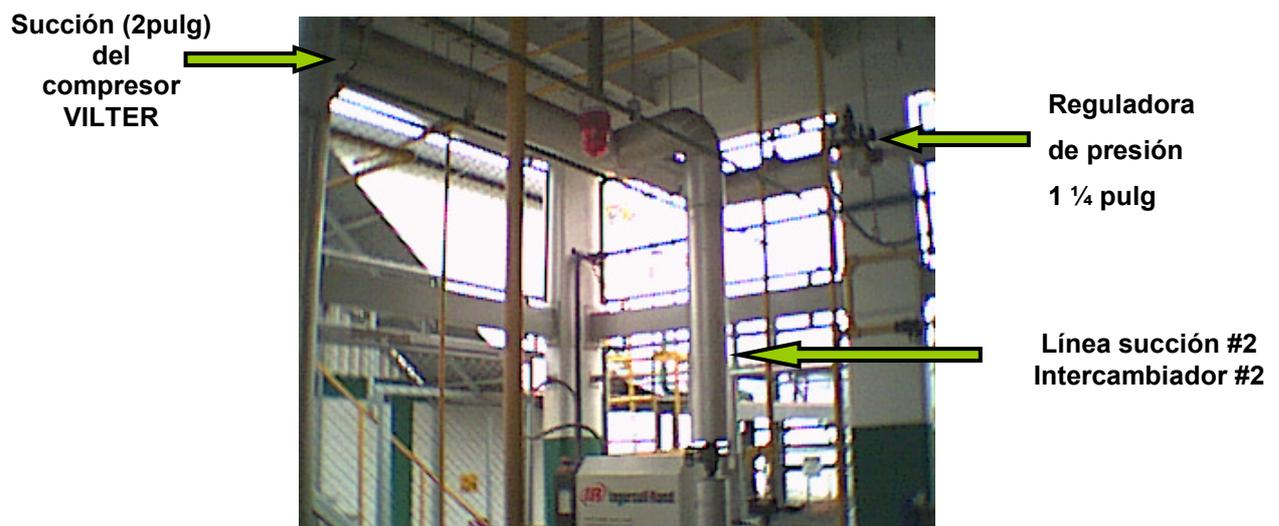
El cambio recomendado de la tubería de succión para el sistema de refrigeración en amoniaco de la planta de piña, se refiere a la **línea #1 de succión**. Debido principalmente a que, la mayor carga térmica demandada (85%) por los equipos de producción es manejada por el intercambiador #1 tipo inundado; por tal motivo se debe cambiar la tubería de succión de **2 a 3 pulgadas**.
