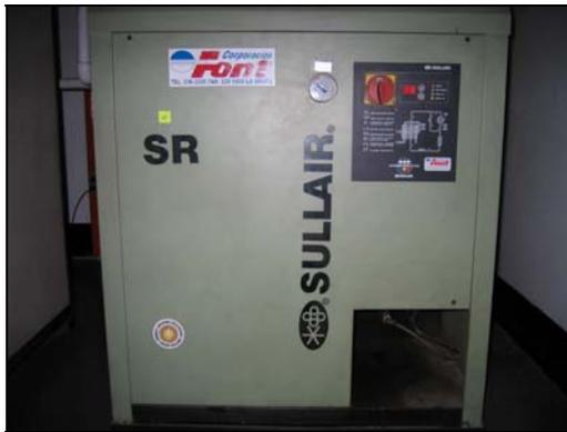
1. Secador para compresor de 75 HP
