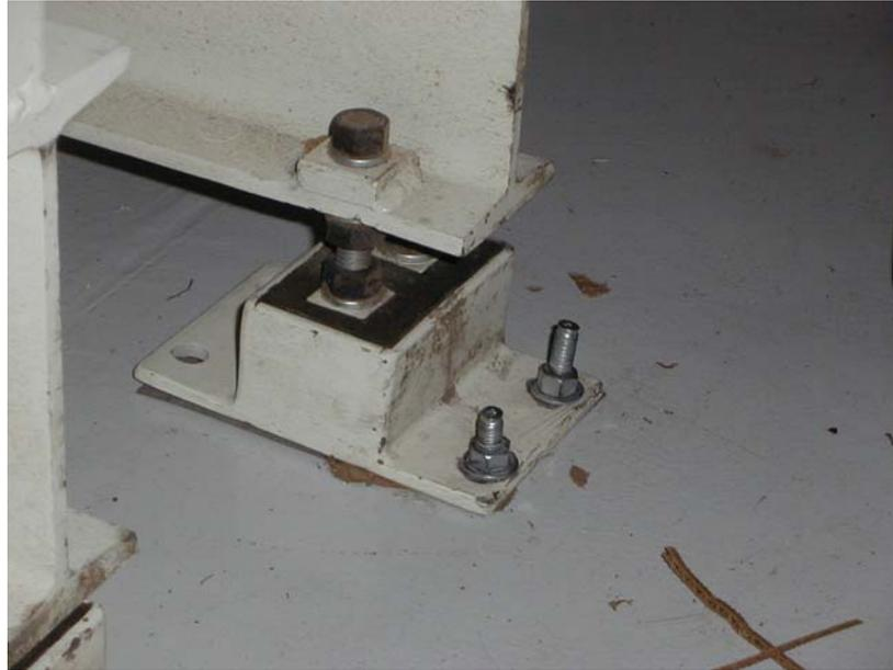
**Figura 3-1** Falta de pernos en base de Turbina 4
