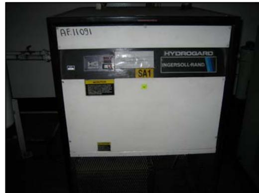
2. Secador para compresor de 50 HP
