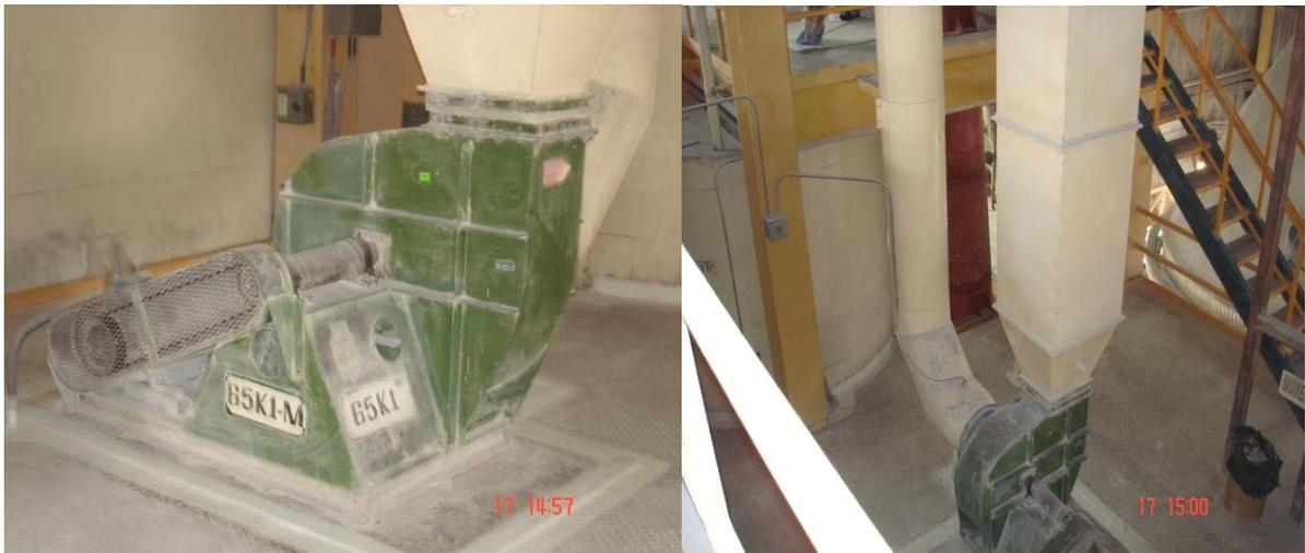
Figura 3.0 Ventilador para succión de polvo de la torre de secado.
