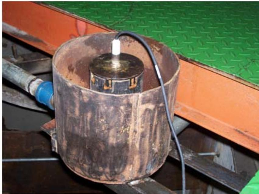
Figura 4.20 Montaje del sensor de pH.
