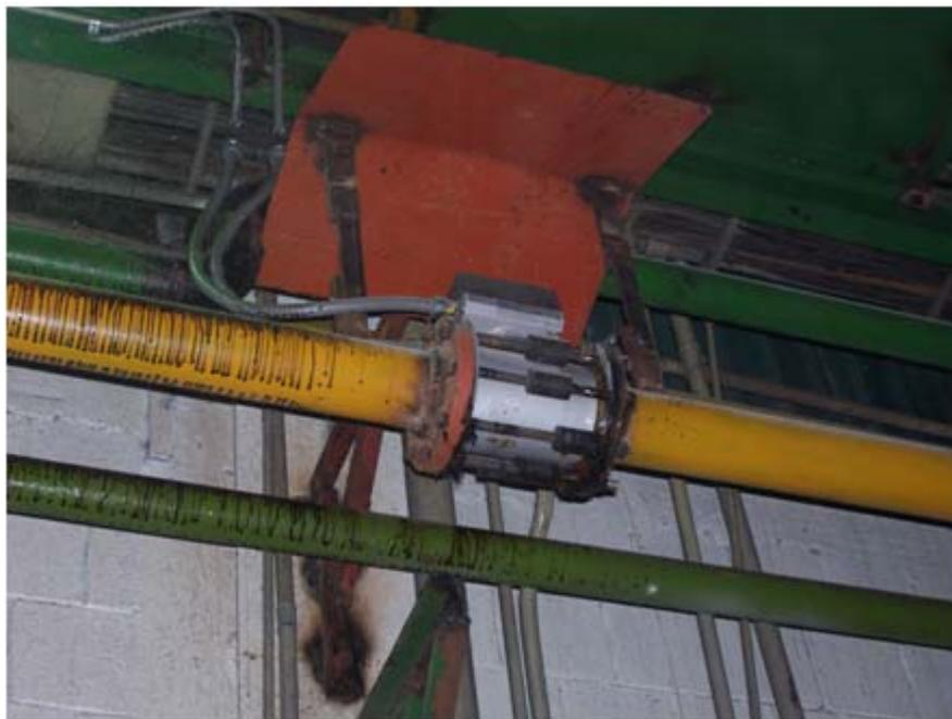
**Figura 4.13** Montaje del transmisor de flujo Optiflux1000.
