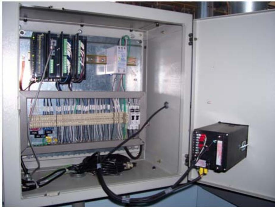
**Figura 4.3** PLC LC-700 instalado para el control automático de evaporadores.
