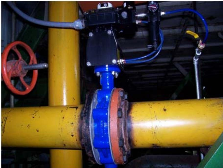
**Figura 4.19** Válvula electro-neumática instalada para la regulación del flujo de meladura.
