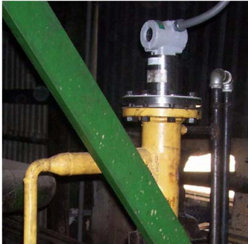
**Figura 4.11** Transmisor de densidad DT-301 instalado para medir el Brix de la meladura.
