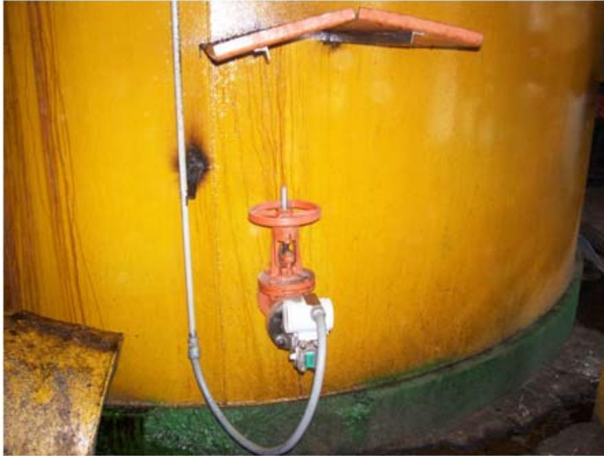
**Figura 4.15** Montaje del transmisor LD-301 en el tanque de jugo claro.
