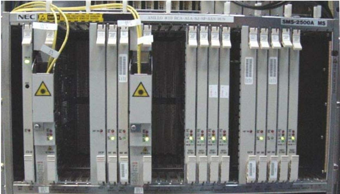
**Figura 4.7** Fotografía del subbastidor MS instalado.
