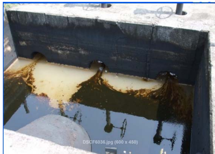
Figura 50. Punto de dosificación de Floculante
